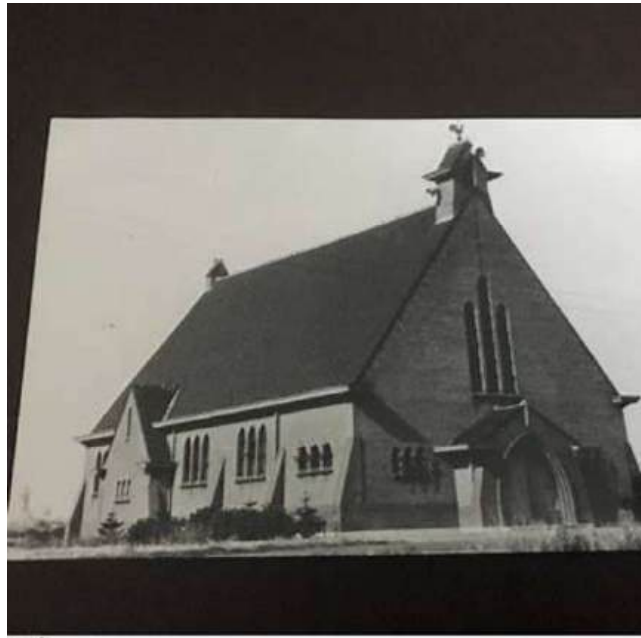
Zijaanzicht van de eenbeukige kerk. Zichtbaar zijn de bakstenen steunberen tussen de traveeën en de eenvoudige spitsboogvensters (per twee gekoppeld).
